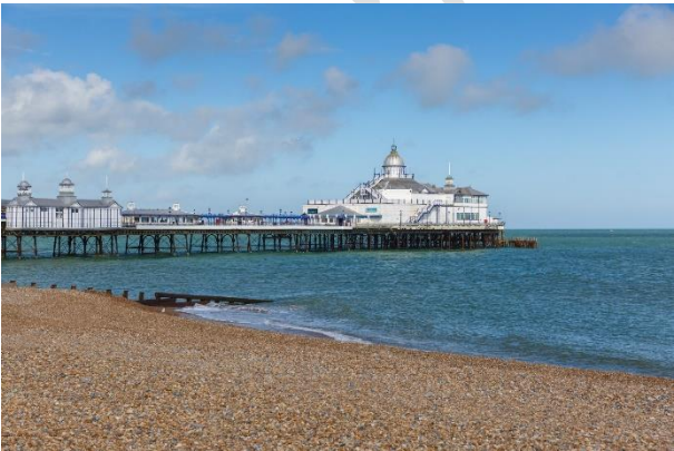
Fig. A.11. Piers
